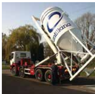
Plaatsing van de silo
