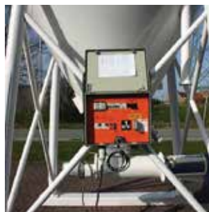
Aansluiting van de elektriciteit
